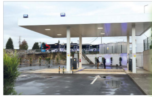
A 1.ª fase de requalificação do Parque de Material e Oficinas dos TUB já é uma realidade
